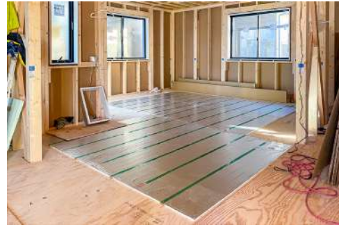
リビング床暖房(施工画像)
