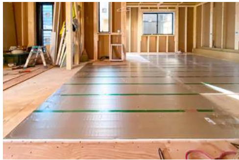
リビング床暖房(施工画像)
