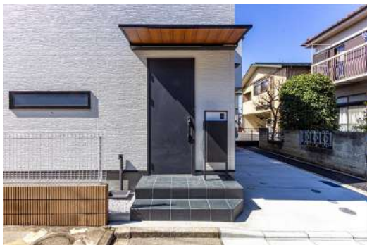
玄関前庇(LED照明)・スマート宅配ポスト
