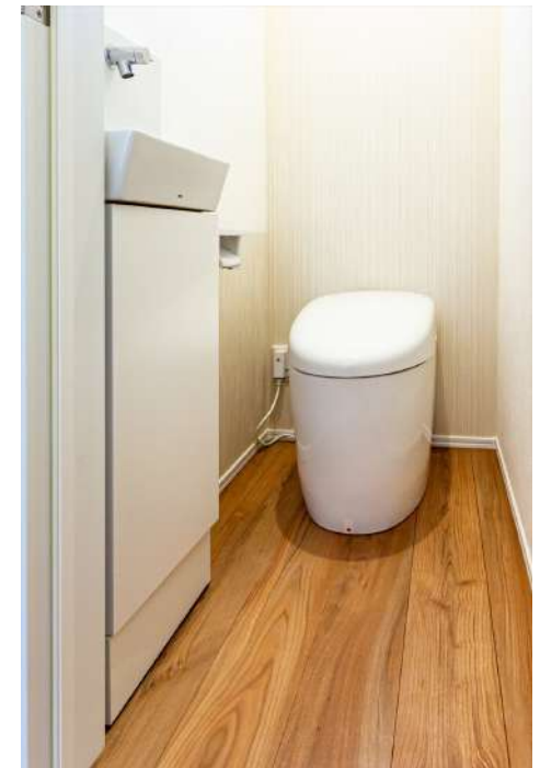
2階 タンクレストイレ レストルームドレッサー
