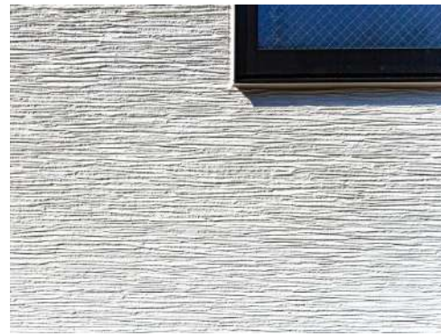
外壁(サイディング)
