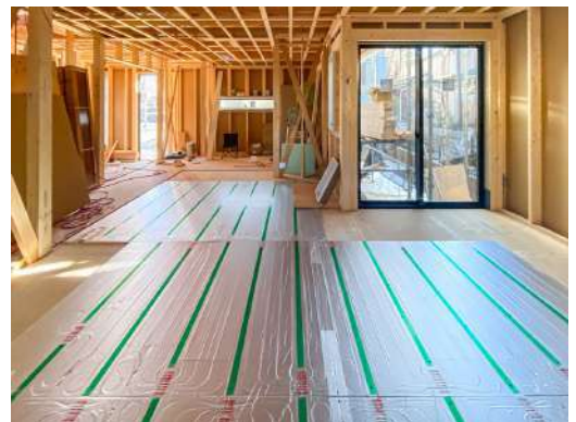
現地施工時の画像。
