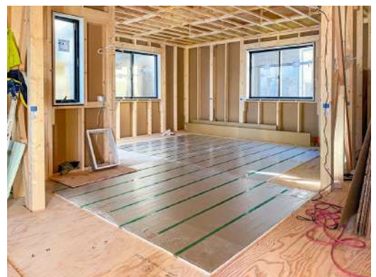
現地施工時の画像。
